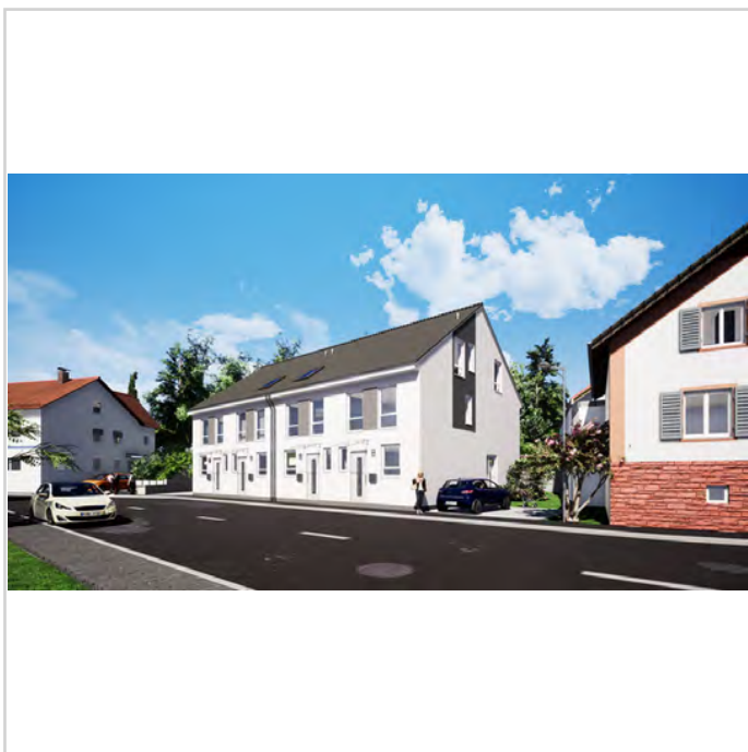
Ansicht von Straße
